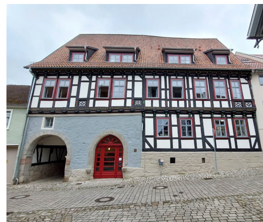
Ansicht straßenseitig nach Sanierung © ProjektStadt
